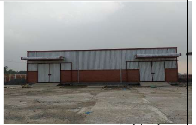
ধানুয়াকামালপুর স্থলবন্দরে ওয়ার হাউজ নির্মাণের চিত্র
