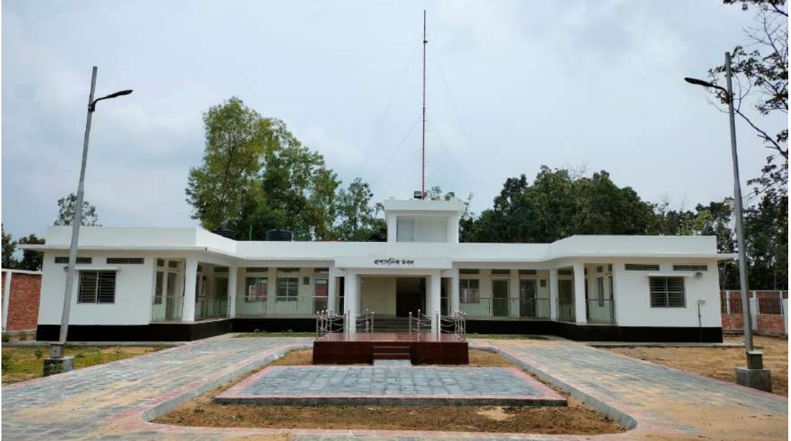
চিত্র: গোবড়া-কড়ইতলী স্থলবন্দরের প্রশাসনিক ভবন
