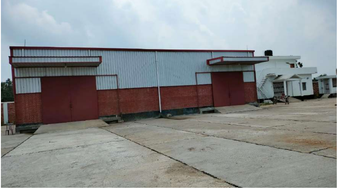
চিত্র: গোবড়াকুড়া-কড়ইতলী স্থলবন্দরের নবনির্মিত শেড
